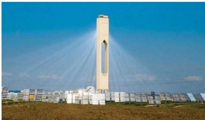
17-сурет. Севильядағы күн электр станциясы (PS1), Испания
