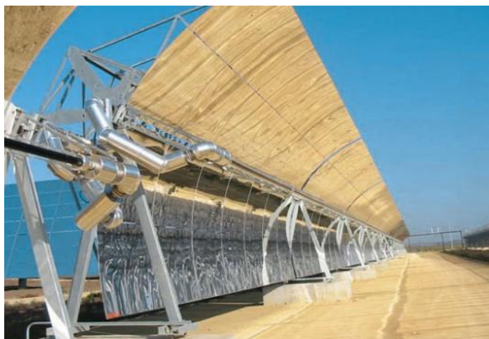
20-сурет. Салқындатқышты жылытуға арналған құбырлары бар ұзын парабодалық (көлденең қимада) айналар
